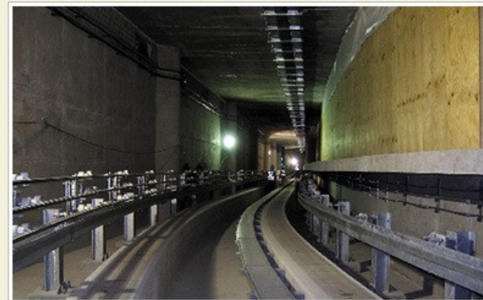
HK International Airport - Skyplaza APM Guide Rail Fabrication 香港國際機場-航天廣場旅客捷運系統-路軌
