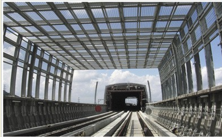
West Rail High Tension Cable Guard & Noise Enclosure Project 西鐵高壓電纜保護及隔音屏障項目
