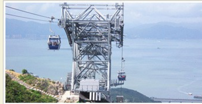
"Ngong Ping 360" Tower Structure Fabrication "昂坪 360" 旅遊景點塔構件製作
